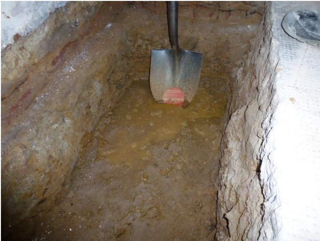
Foto 1: Foto von Schurf im Untergeschoss des bestehenden Verwaltungsgebäudes (aus dem Jahr 2013, erhalten durch am 22.02.2024)
