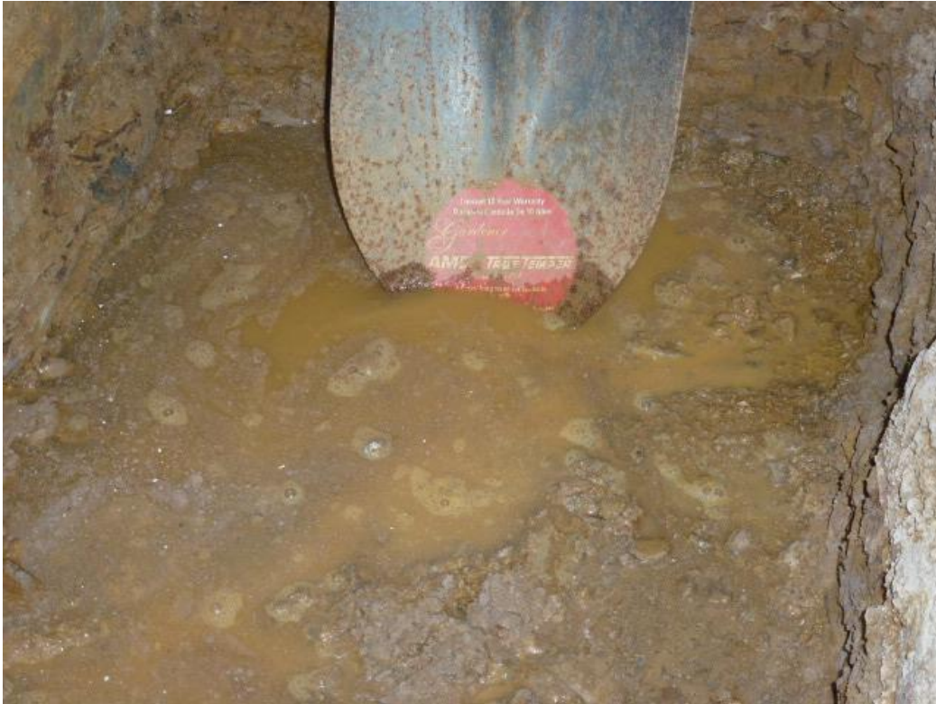
Foto 2: Detailfoto von Schurf im Untergeschoss des bestehenden Verwaltungsgebäudes (aus dem Jahr 2013, erhalten durch am 22.02.2024)
